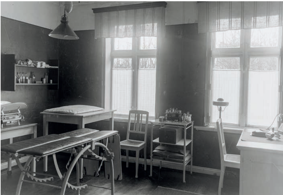
Büro der Fürsorgerinnen in einer Schule in der Küterstraße. (Foto: StAK Album Nr. 165)
