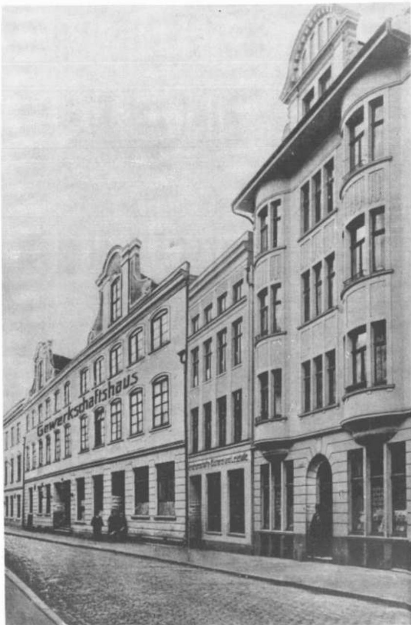
Das Lübecker Gewerkschaftshaus in der Johannisstraße (heute: Dr.-Julius-Leber-Str.), gegen Ende des 19. Jahrhunderts errichtet. Hier konnten viele Aktivitäten organisiert werden und stattfinden. Links das eigentliche Gewerkschaftshaus, in der Mitte die Bücherei und Lesehalle, rechts die Druckerei.
